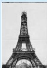
Pour construire le 2ème et 3ème étage on utilisera des grues.
